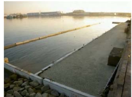
平成 21年度 堺泉北港堺2区生物共生型 護岸築造工事(大阪府)
