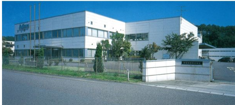
工場全景(藤倉航装(株)船引工場)
