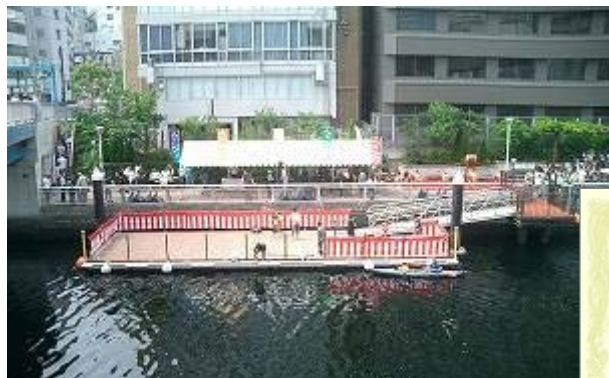
浮き棧橋全景
