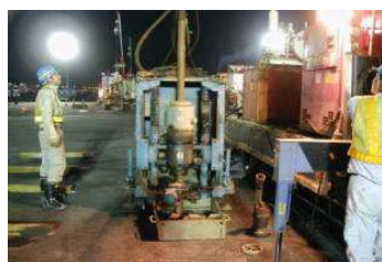
ボーリング削孔状況
