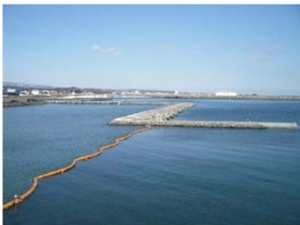
白老港土砂処分場B部その他建設工事 (北海道)
