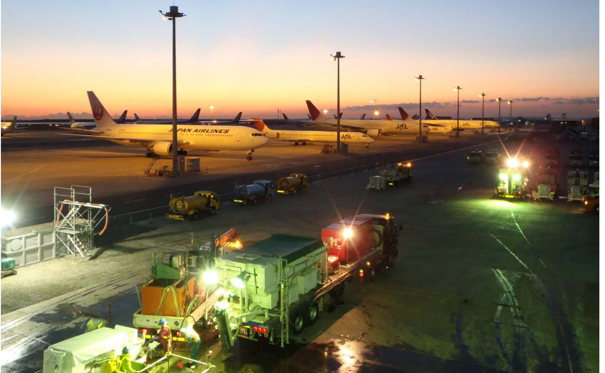
当社保有技術CPG工法による東京国際空港C滑走路地盤改良工事
