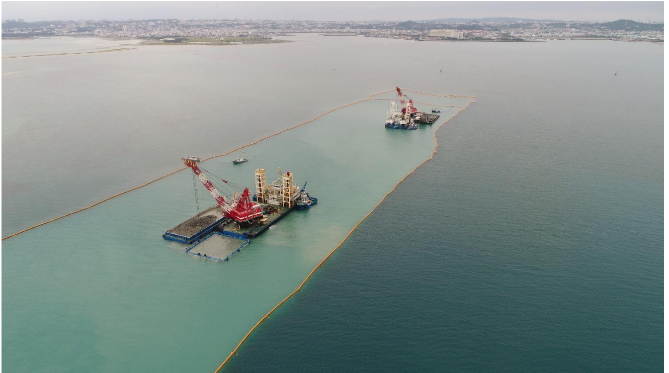
中城港湾浚渫工事
