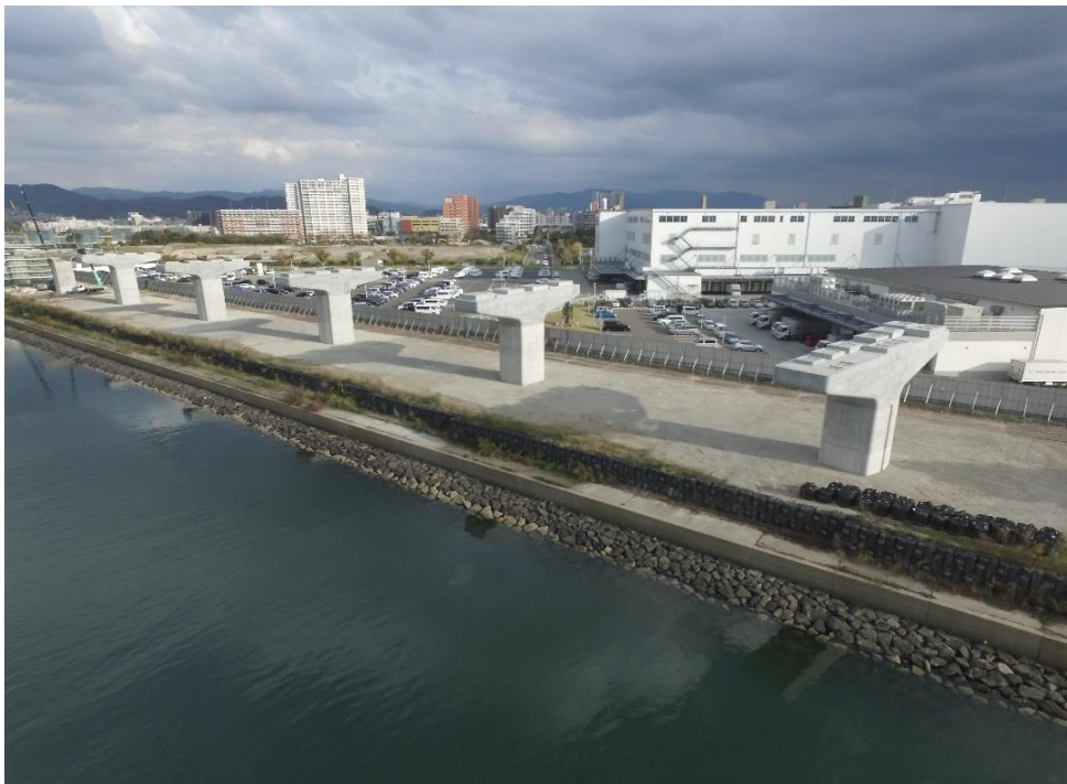
博多港(アイランドシティ地区)道路(IP17~IP21)橋梁下部工事
