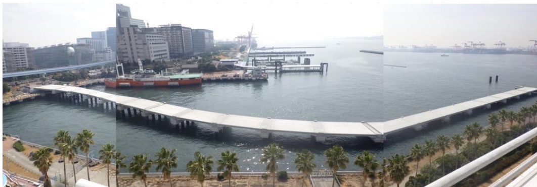
13号地新客船ふ頭岸壁(-11.5m)連絡通路建設工事
