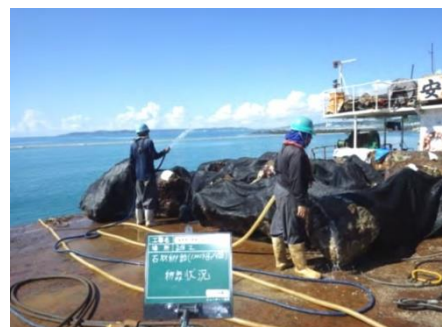
② 遮光シート設置状況
