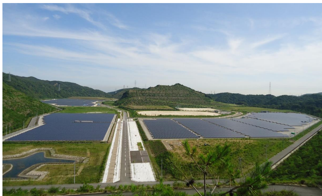
太陽光発電所新設工事(和歌山県)
