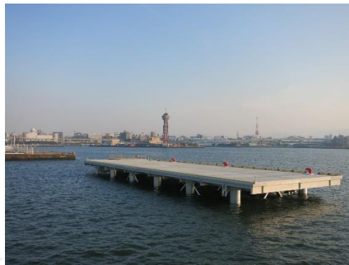
博多港ジャケット据え付け
