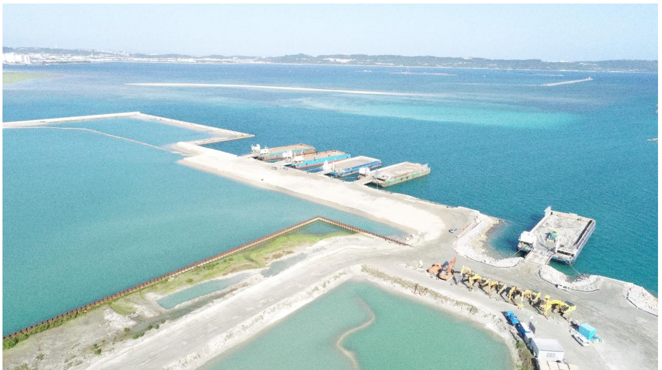
中城港湾浚渫工事
