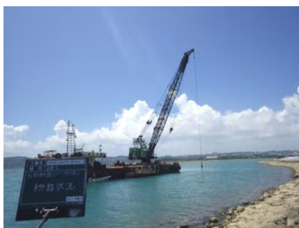
③ 移設状況
