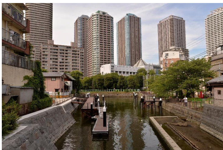
佃公園整備工事
