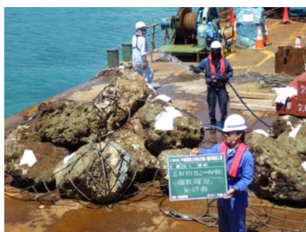
① 海水散水状況
