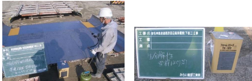
環境にやさしい水性剥離剤の使用
