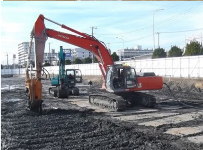
パワーブレンダー工法施工
