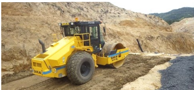
重機のICT施工
