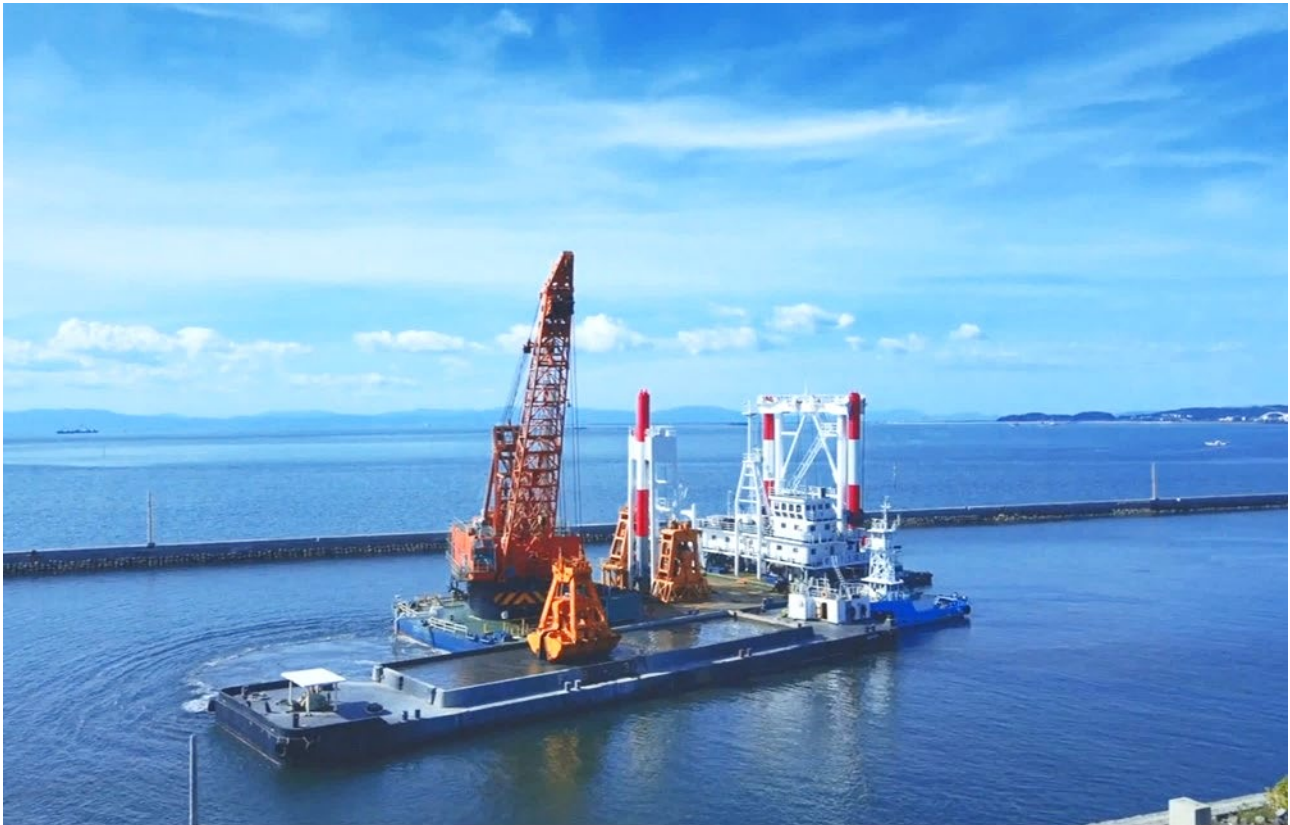
令和3年度三池港(内港北地区)航路(-10m)浚渫工事【福岡県】
