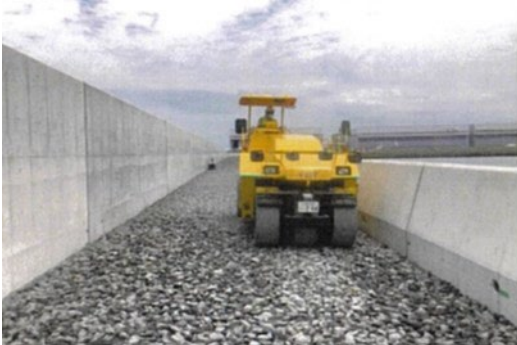
タイヤローラーで路盤転圧
