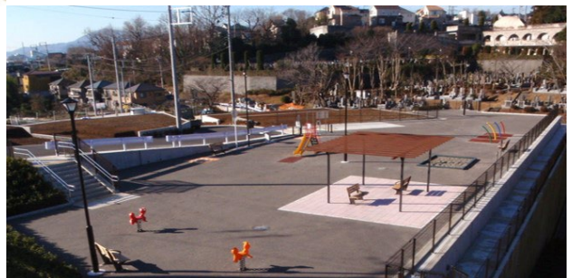
宅地内の公園施工 ※公園下は調整池
