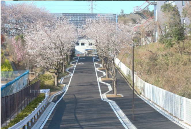
桜の木を残した道路施工
