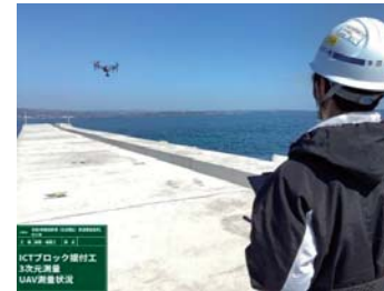
▲UAV (ドローン) 出来形測量状況
