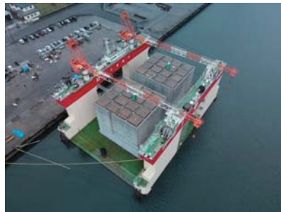
▼令和4年度志布志港(新若浜地区)岸壁 ケーソン製作工事
