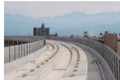
▼北陸新幹線 富山稲荷千歳高架橋
