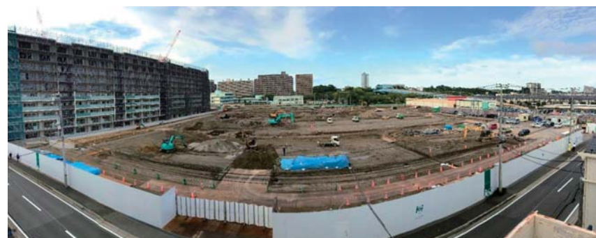
▲2023年5月現在、擁壁築造やインフラ工事を行っています。
