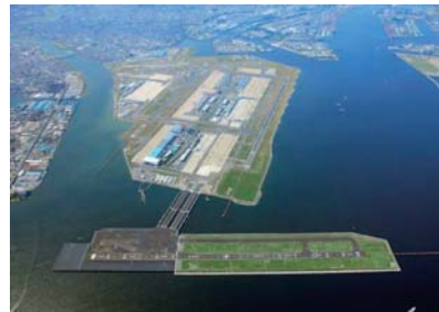
▼東京国際空港D滑走路建設他工事
