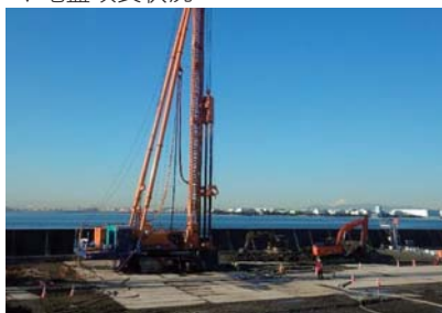
▼地盤改良状況
