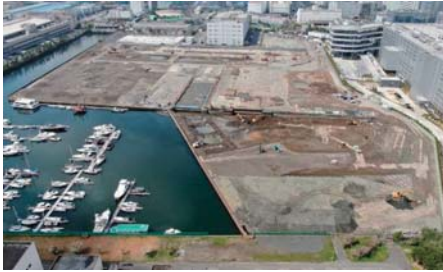
▼砂町開発 マリーナ水域埋立・護岸新設工事
