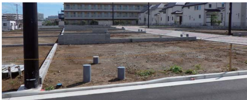
▲ (仮称) 戸塚区前田町計画宅地造成工事
