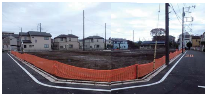
▲ (仮称) 東京都小平市御幸町③計画宅地造成工事
