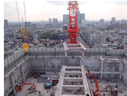
▼(仮称)西麻布三井ビルディング解体工事
