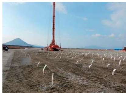
▲プラスチックボードドレーン施工状況
