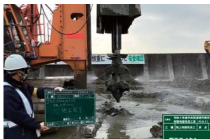
▲地盤改良後の様子
