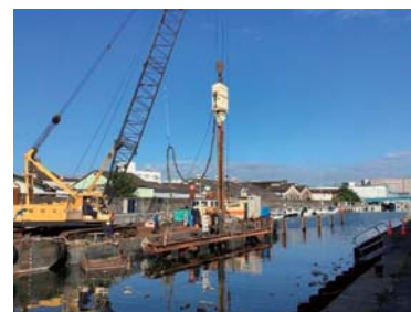
▲鋼矢板打設状況
