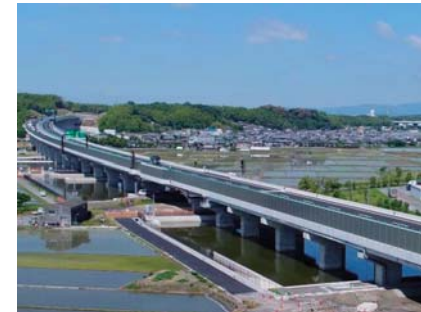
▼新名神高速道路 京田辺高架橋西(下部工)工事
