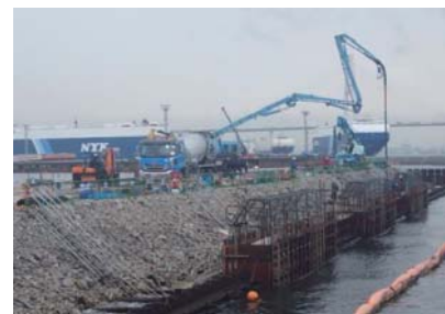
▲上部コンクリート打設状況
