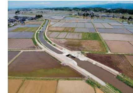
▼横手西部農業水利事業 吉田幹線排水路(その16)工事
