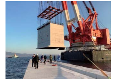
▲ケーソン据付状況
