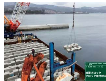
▲被覆ブロック据付状況
