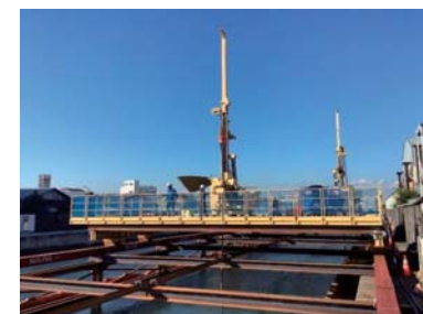
▲地盤改良状況
