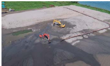
▲排土・かき揚げ状況
