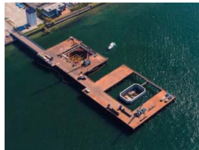
▼川崎港臨港道路東扇島水江町線 主橋梁部（MP3）橋梁下部工事
