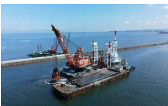
令和5年度三池港(内港北地区)航路(-10m)浚渫工事
