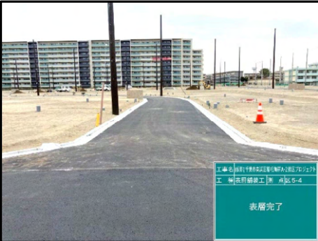
▲舗装完了全景
