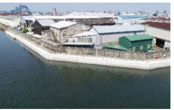
大正区鶴町5丁目(E-25)堤防工事(その2)
