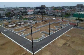
(仮称)豊四季計画 宅地造成工事
