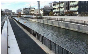
北十間川護岸整備工事(その12)その3
