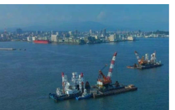
令和5年度博多港(箱崎ふ頭地区)航路・泊地(-12m)(改良)浚渫工事
