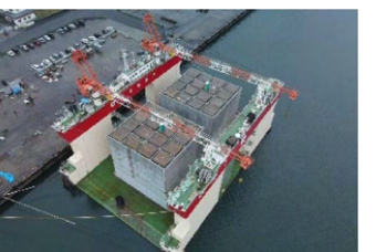
令和4年度志布志港(新若浜地区)岸壁ケーソン製作工事
