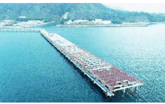
徳山下松港下松地区栈橋(-19m)築造工事(その2)
