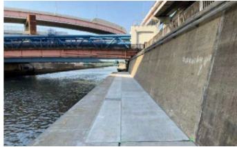
綾瀬川護岸耐震補強工事(その216)その2
