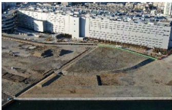
砂町開発マリーナ水域埋立・護岸新設工事
