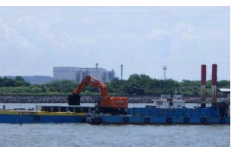
大牟田港航路浚渫工事
