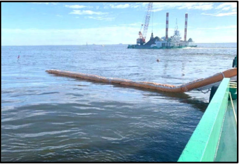
▲汚濁防止膜設置状況
