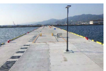
令和3年度鹿児島港(谷山二区)係留施設築造工事
