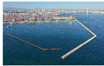
新本牧ふ頭建設工事(その28・外周護岸B-2基礎及び本体工)
