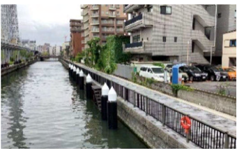
北十間川護岸整備工事(その33)
