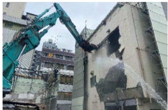
(仮称)台東区浅草橋一丁目計画 解体工事
