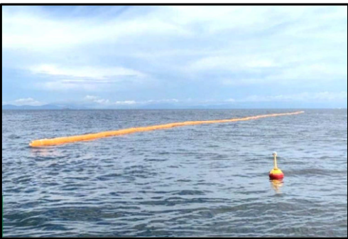
▲汚濁防止膜設置完了
