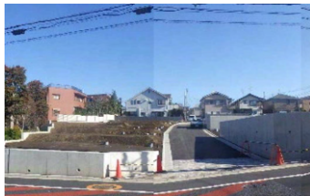
(仮称)東京都杉並区上井草二丁目②計画 宅地造成工事
