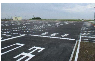
MOP木更津P11駐車場アスファルト化工事
