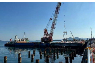
令和5年度佐伯港(女島地区)岸壁(-10m)(改良)上部工撤去工事
