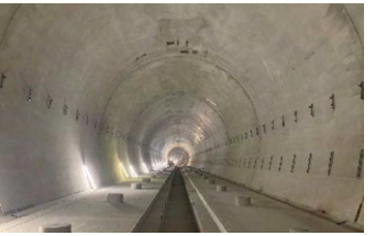
北陸新幹線、加賀トンネル(中)
