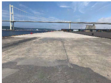
室蘭港祝津地区-11m岸壁改良工事
