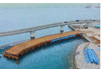
令和3年度那覇港(新港ふ頭地区)臨港道路(若狭港町線)橋梁仮橋工事
