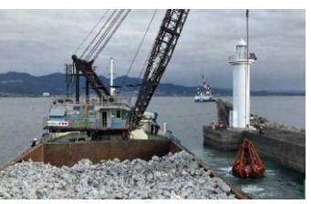
令和5年度別府港(石垣地区)防波堤(改良)築造工事
