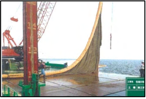
▲汚濁防止膜撤去状況
