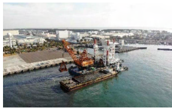
令和4年度 大井川港航路(港口部)埋没対策ほか浚渫工事
