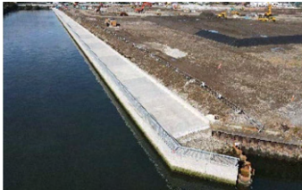
令和4年度 砂町北運河(新砂二丁目)内部護岸建設工事
